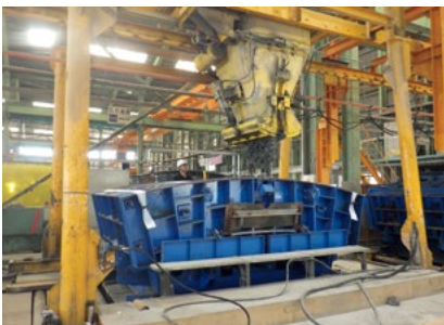
3 コンクリート打設
