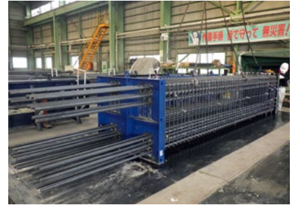
2 型枠組立/鉄筋・金物取付
