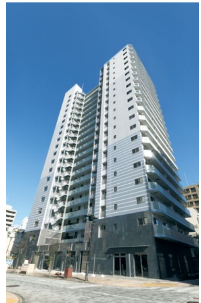
エンブルタワー七間町(住宅) 柱・梁 静岡県
